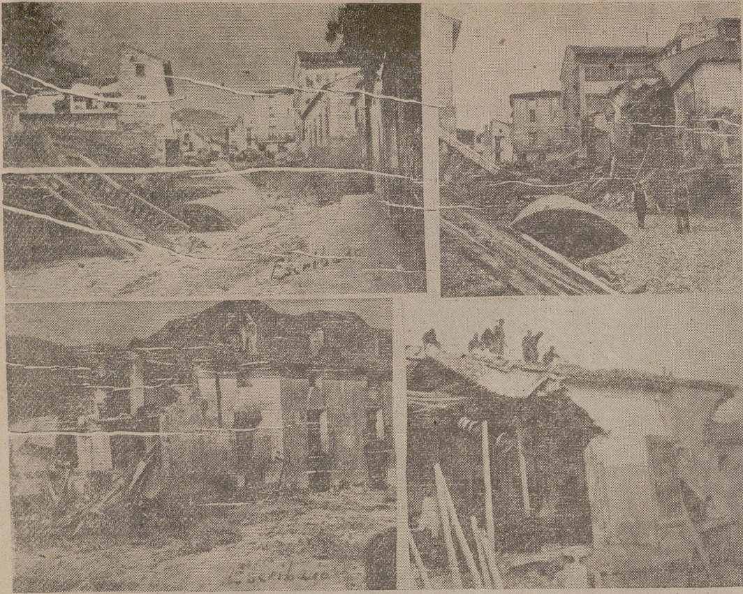
Diversos aspectos de los grandes daños producidos en Cervera del Río Alhama por las últimas inundaciones padecidas por la expresada localidad. (Fotos Escribano).
