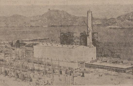
El fuel-oil se inyecta en las calderas mediante unos atomizadores que actúan a 25 kilogramos de presión por centímetro cuadrado. La inmensa masa de gases que producen estas calderas es expulsada al exterior por dos chimeneas tronconómicas de 65 metros de altura, 785 metros de diámetro en su base y 450 metros de diámetro en la coronación.
