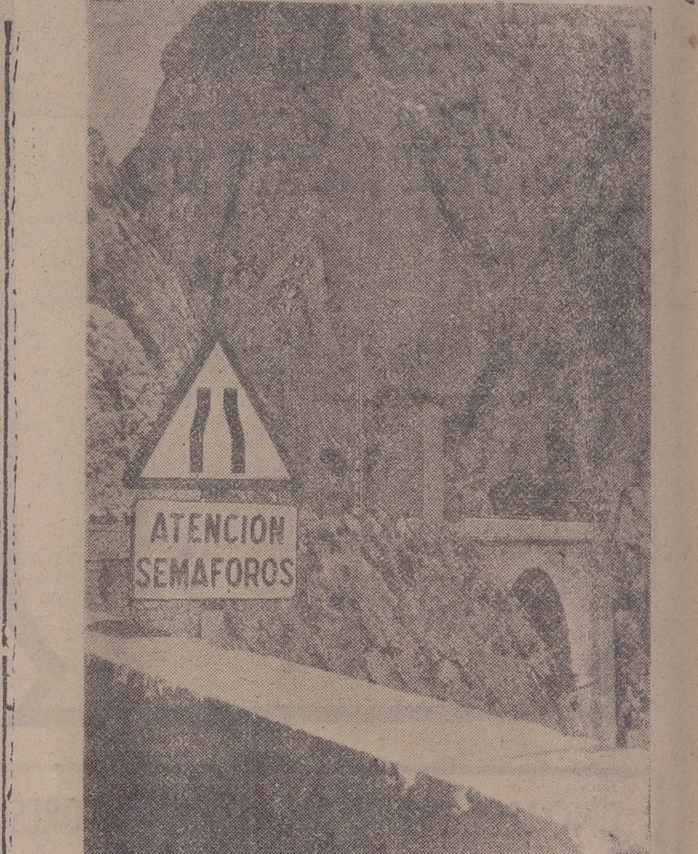
Una señalización con semáforo, oportunamente dispuesto en la carretera N-340 (Alicante), permite el difícil paso del Marcarat con garantía y orden.
