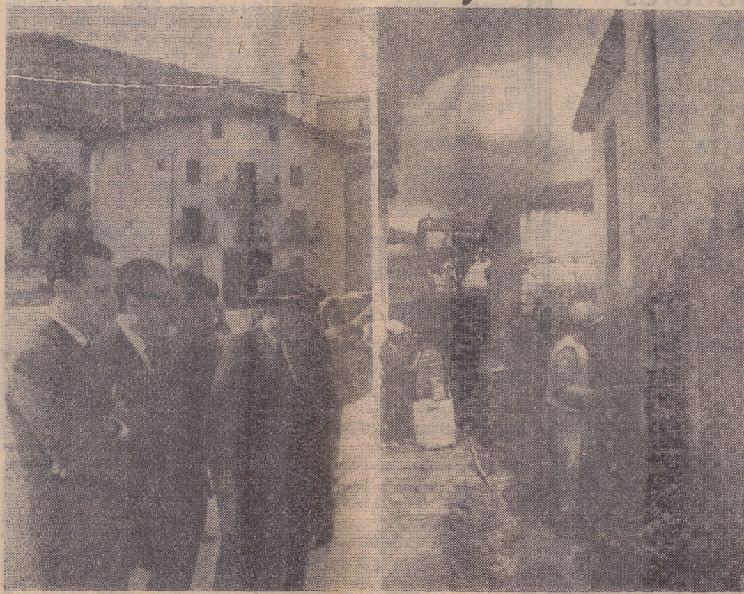
El señor gobernador civil, don Ramón Castilla Pérez en Villanueva de Cameros. Nuestra primera autoridad ad provincial contempla las obras de enlucido de edificios en Lumbreras
