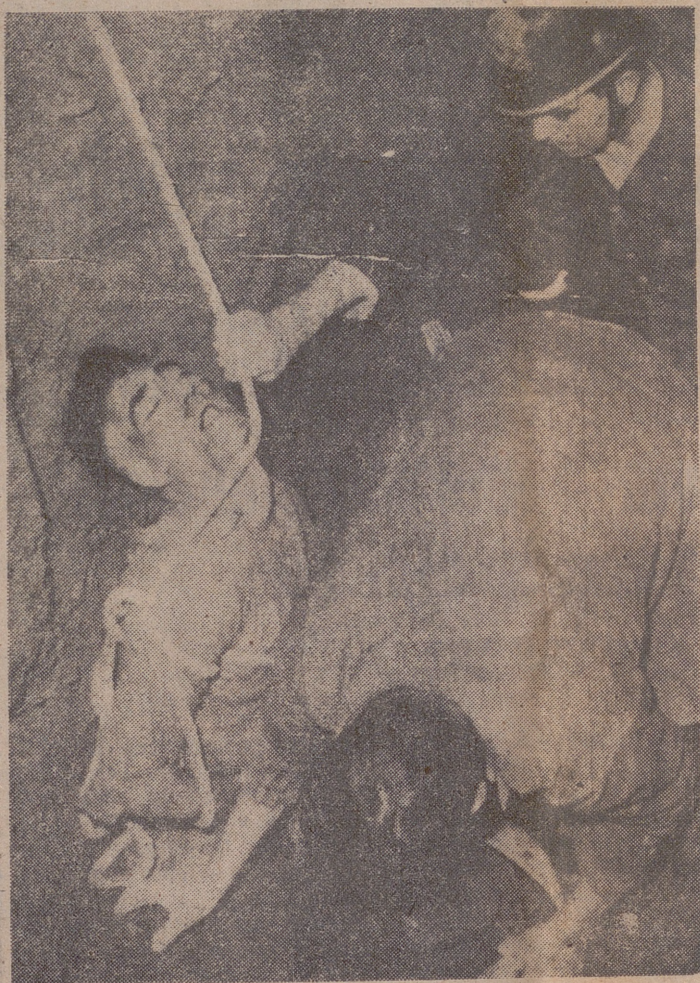
BARCELONA. — Dos muertos y otros dos obreros heridos ha sido el balance del derrumbamiento de una casa en construcción en la calle Santa Coloma, de San Andrés. Los muertos fueron los obreros Antonio López Busto y Aurelio Guerra. (Foto "Europa Press")
