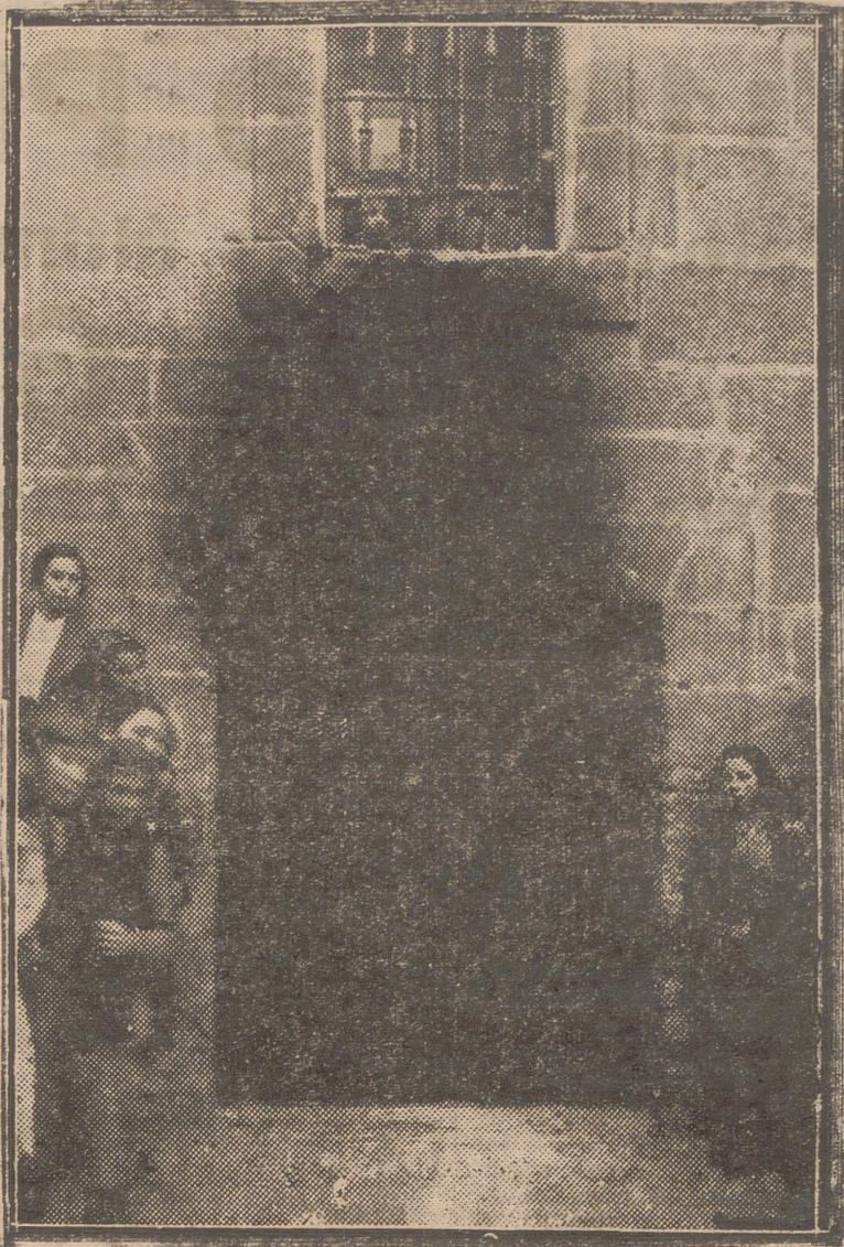
HARO.— LA PUERTA DEL DEPOSITO DE FAROLES DEL ROSARIO, DE LA BASILICA DE LA VEGA, QUE SE PRETENDIO QUEMAR LA NOCHE DEL JUEVES SANTO
