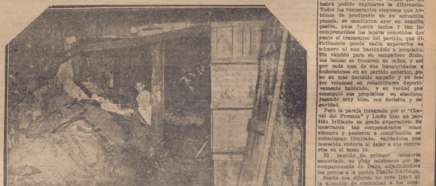
ESTADO EN QUE QUEDO LA DEPENDENCIA EN QUE SE PRODUJO LA EXPLOSION
