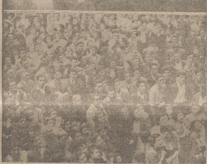
Algunos de la bendición e inauguración de las instalaciones de la traida de aguas a Cenicero, y el vecindario estacionado bajo los balcones del Ayuntamiento, escuchando a los oradores. (Fotos Payá)
