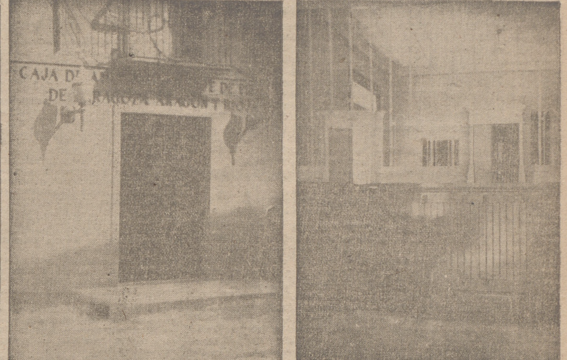
Fachada de la Sucursal de la Caja de Ahorros y Monte de Piedad de Zaragoza, Aragón y Rioja, y aspecto parcial de la instalación de las oficinas inauguradas en Cervera del Río Alhama.
