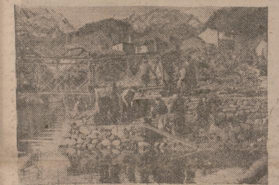
RIBADELAGO (Zamora). — Los zapadores del VII Cuerpo de Ejército, con la colaboración de los paisanos, proceden al montaje del puente metálico, con una capacidad de carga de 30 toneladas, que sustituye al de madera destruido por la dramática riada. — (Foto Cifra).
