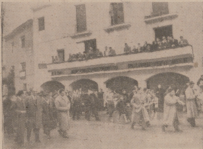
La comitiva se traslada al edificio de las escuelas nacionales
