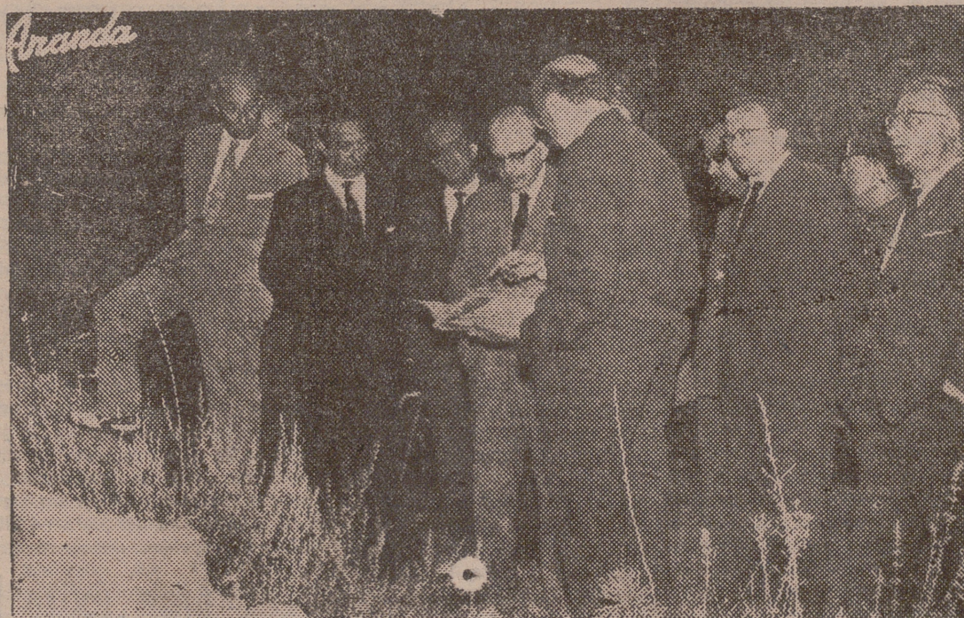
El ministro de Obras Públicas, en el lugar en que se verifica la toma de aguas para el nuevo abastecimiento de aguas de Logroño.
