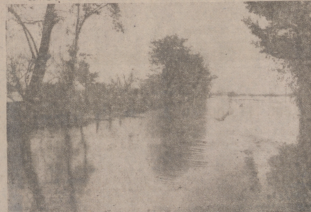
Aspecto que ofreció, a causa de los últimos temporales de agua y viento, la carretera que va de San Adrián a Calahorra, cortada por el río Ebro en la vega.
