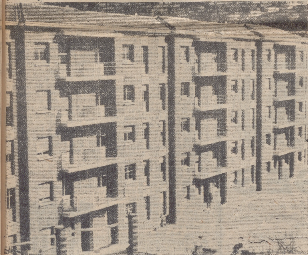
Grupo de «Vivienda Timoteo Ruiz», construido por la empresa Hijos de Timoteo Ruiz, S. A., para sus productores. —(Foto Mur).
