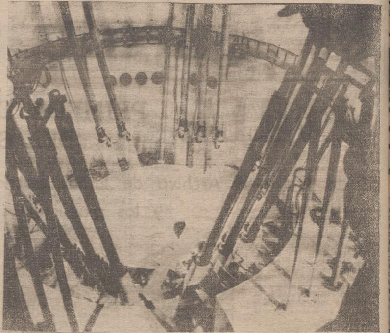
El mayor reactor atómico del mundo que trabaja con agua pesada está instalado en el Centro de Investigaciones Nucleares de Karlsruhe (República Federal de Alemania). Ha sido construido por la «Siemens Schucker». En la foto vemos un aspecto interior del mismo, precisamente el reactor. — (Foto «Fiel»).
