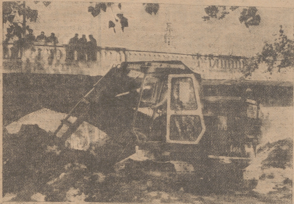
Una potente excavadora inicia las obras de las piscinas.
