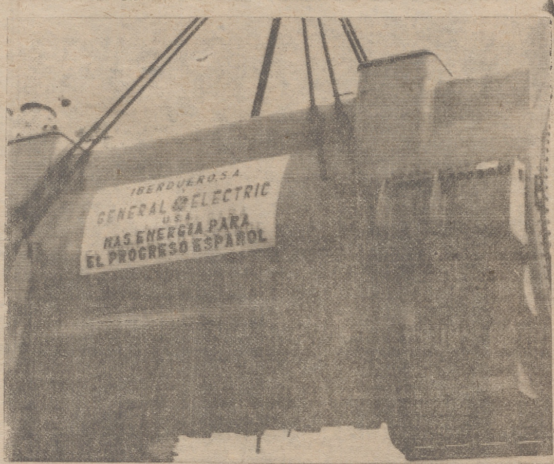
BILBAO, --- Momento de la descarga desde la motonave «Guadalupe» de un «stator» destinado a la central térmica de Santurce. El «stator» pesa 250 toneladas y para la maniobra ha sido precisa la construcción de una grúa con 600 toneladas de bloques de hormigón para guardar el contrapeso. (Foto «Cifra Gráfica»)
