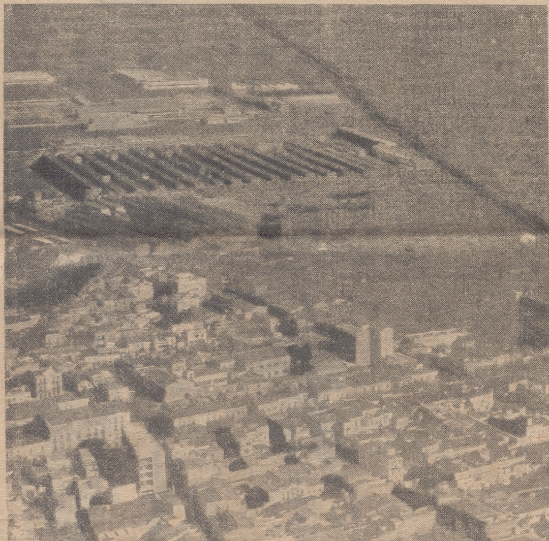
Vista aérea del complejo industrial de Compañía Roca-Radiadores, en Gavá.
