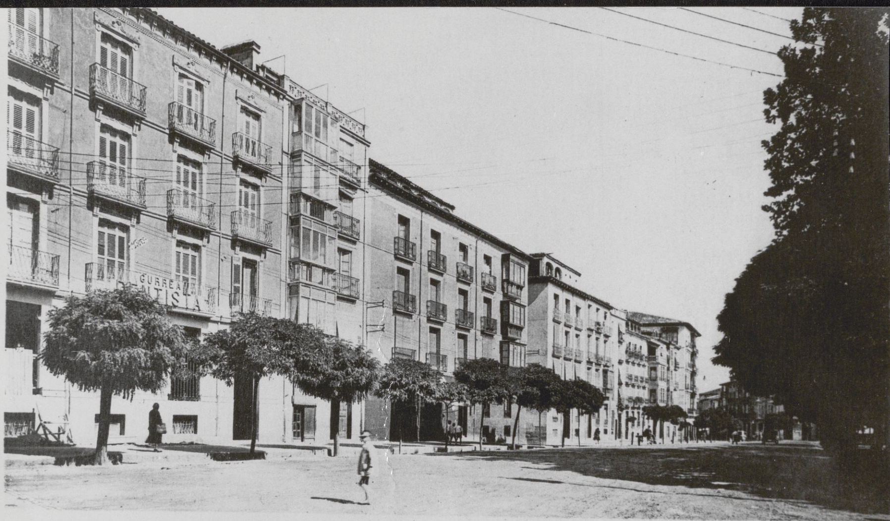
34. LOGRONO — Muro del Carmen
