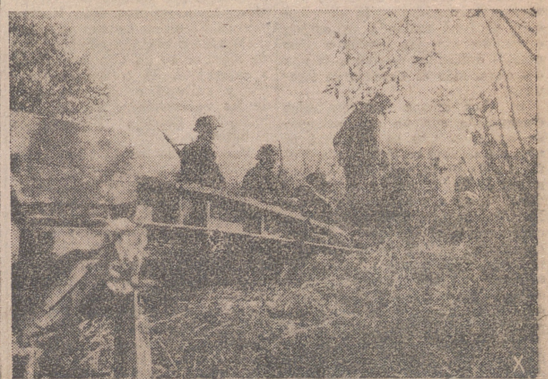
Los zapadores alemanes han construido un sólido puente de madera que facilita el paso de tanques y camiones sobre el río. (Foto Orbis)
