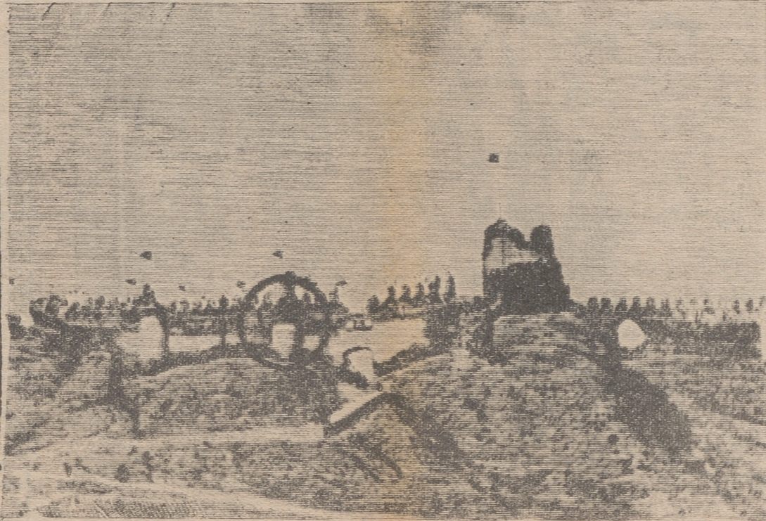
En el círculo aparece el torreón que se derrumbó por acción de las lluvias. El resto del castillo correrá la misma suerte si no se toman las medidas necesarias para su conservación. (Foto "Jusam").
