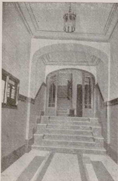
Entrada a la Cámara
