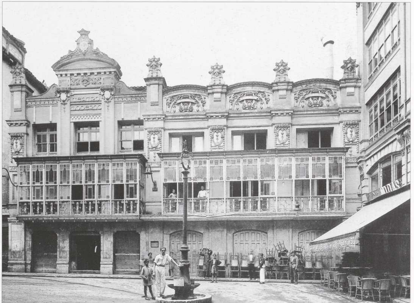
Antigua fachada del Teatro Moderno hacia 1920.
