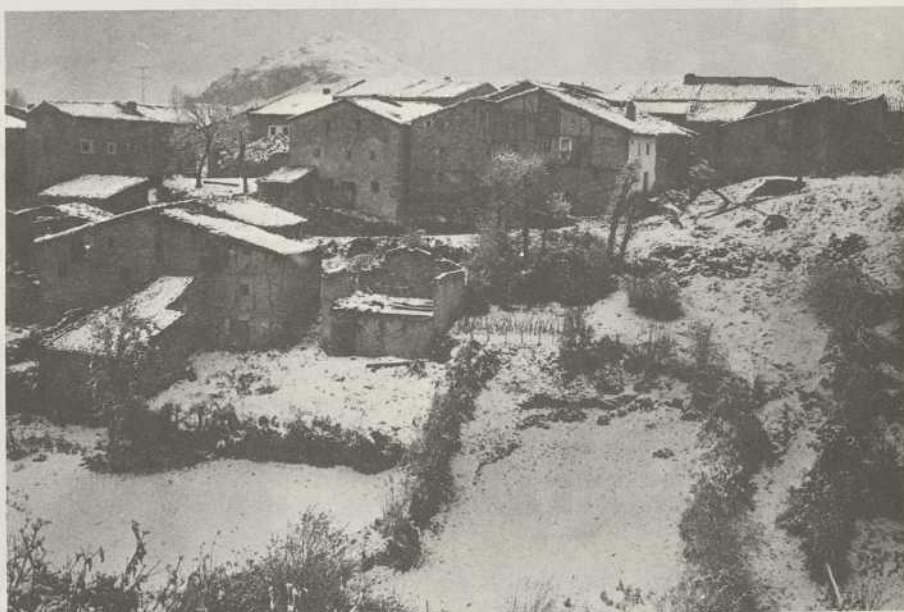
Vista general de Pazuengos
