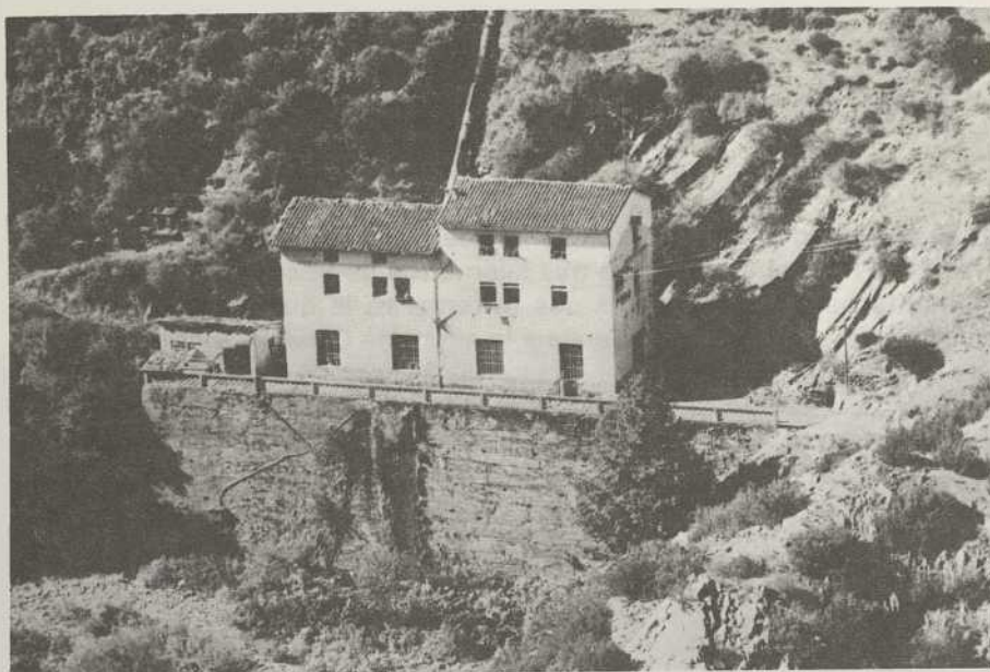
La central hidroeléctrica de Posadas
