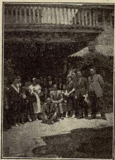
Visita a la casa de El Greco en Toledo
