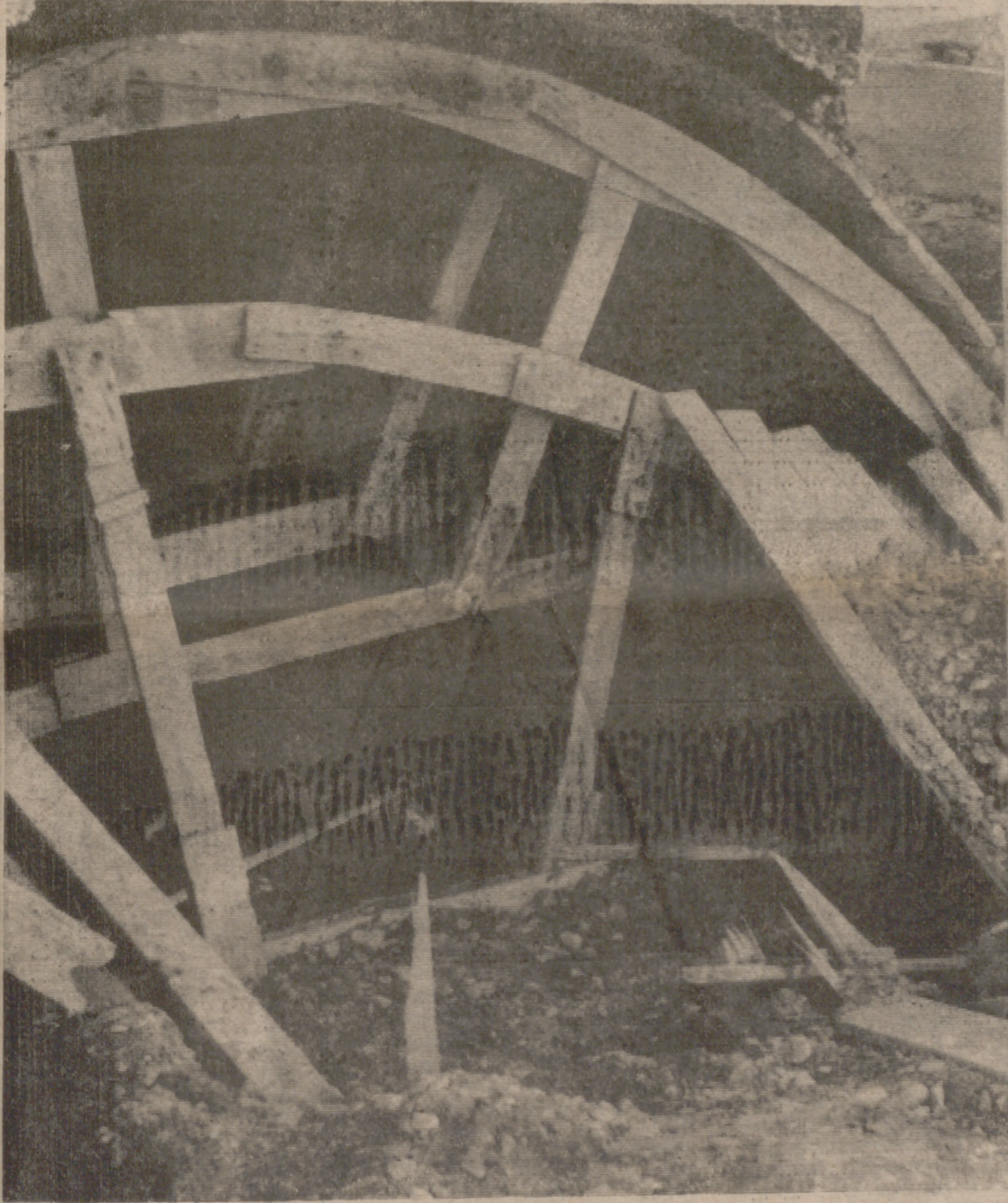
Ayer hubo un trágico accidente en Pradejón. Una bodega de champiñón que se estaba construyendo se vino abajo, a la hora de retirar los soportes. El armazón se vino encima del vecino Francisco Obrero Izquierdo. Traslado a Calahorra, no se pudo salvar su vida. También quedaron gravemente heridos José San Casimiro Ezquerro y Gabino Córdón Ezquerro. Al parecer, las heladas pasadas impidieron que el cemento fraguara lo suficiente. — (Foto HERCE).
