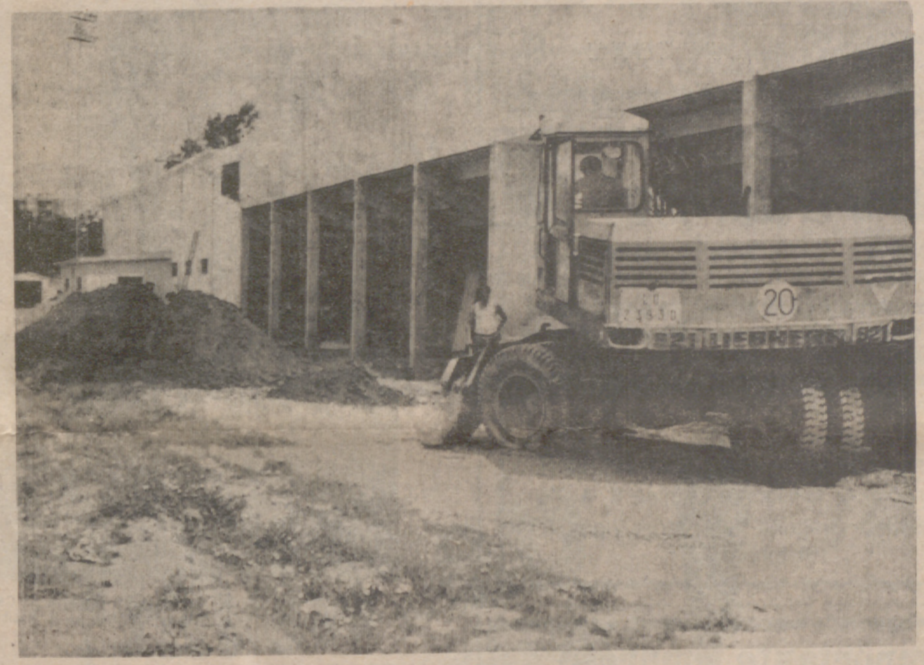
La excavadora trabaja en los cimientos de las columnas que sostendrán la visera de la nueva tribuna. (Foto HERGÉ)
