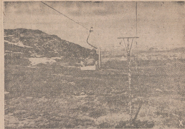
Para salvar los accidentes del terreno, que obligarían a un gran rodeo, los soldados alemanes han instalado este pequeño funicular que les permite atender rápidamente a las principales necesidades de una posición del extremo Norte del frente. — (Foto Orbis)
