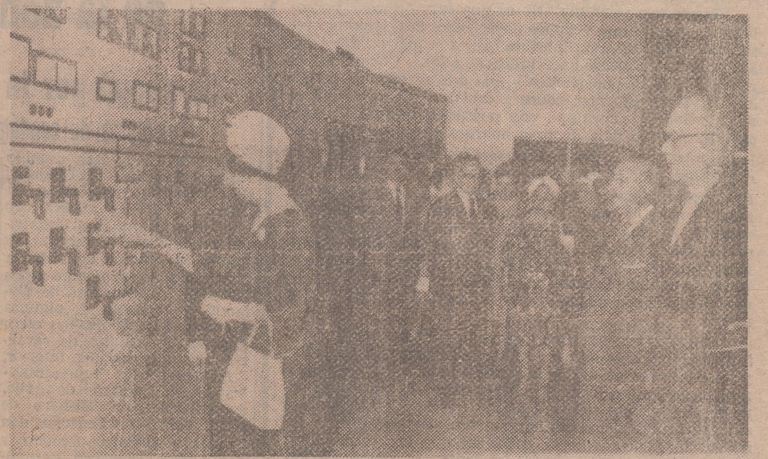
Por Su Excelencia el Jefe del Estado y señora ha quedado inaugurado el embalse y central hidroeléctrica de Valdecañas, sobre el río Tago, en la provincia de Cáceres. En la foto vemos el momento en que doña Carmen Polo de Franco presiona sobre el botón que pondría en funcionamiento la central. — (Foto "Fiel").
