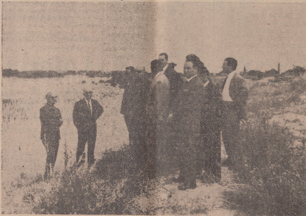
Visita al muro de contención de la margen derecha del Ebro, en Alfaro.
