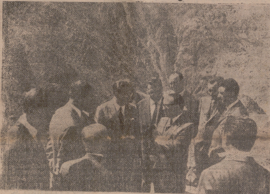
El ministro de Obras Públicas, don Federico Silva, ha visitado las obras de ampliación del suministro de aguas a la capital de España. En la foto vemos al ministro inspeccionando los trabajos de desviación del río Lozoya. — (Foto "Fiel").
