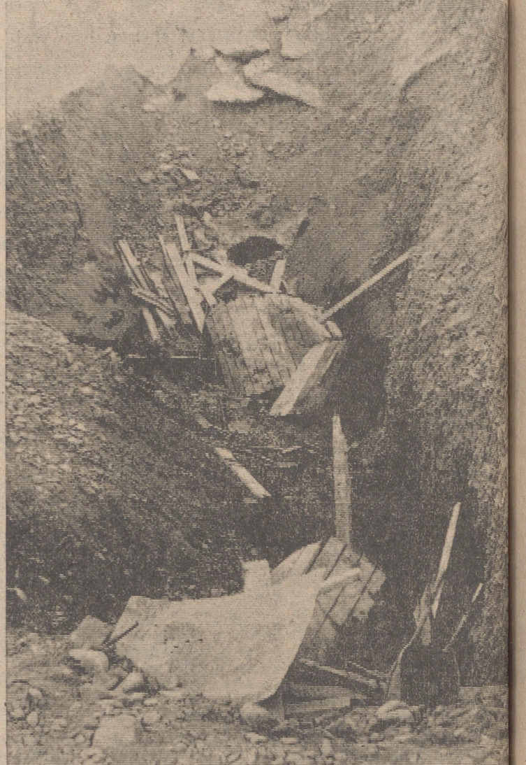
En este lugar se produjo el accidente. Aún puede verse se parte del túnel.
