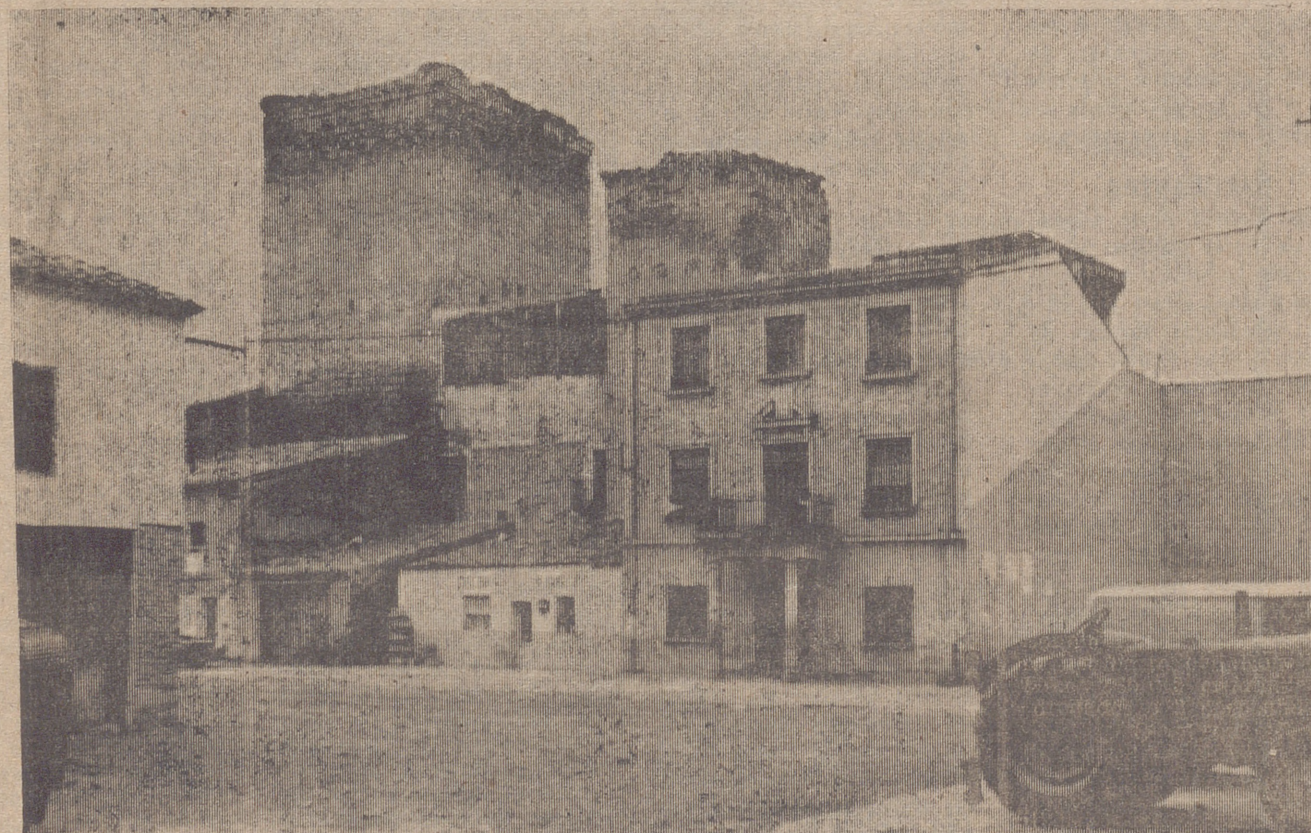
AGONCILLO: Un Municipio donde la infraestructura presenta mayor número de deficiencias.
