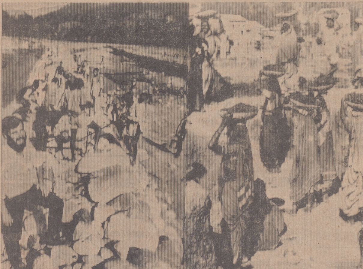
Bajo las condiciones de producción de la India, hombres y mujeres están satisfechos si pueden encontrar trabajo, por ejemplo, en la realización de un proyecto de desarrollo agrario. Nuestra foto doble muestra mujeres indias al pie de una obra (a la derecha) y trabajos de construcción en un dique en las cuevas del Himalaya (a la izquierda).
