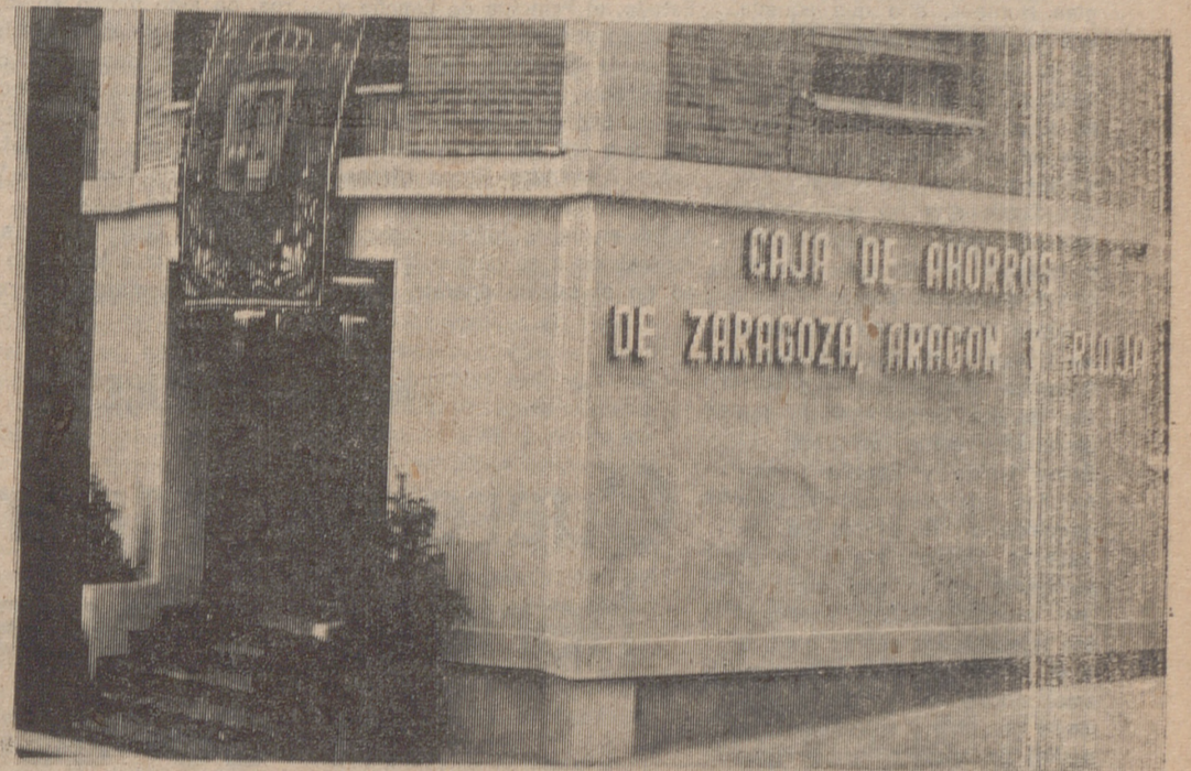
Fachada exterior de las magnificas oficinas inauguradas.
