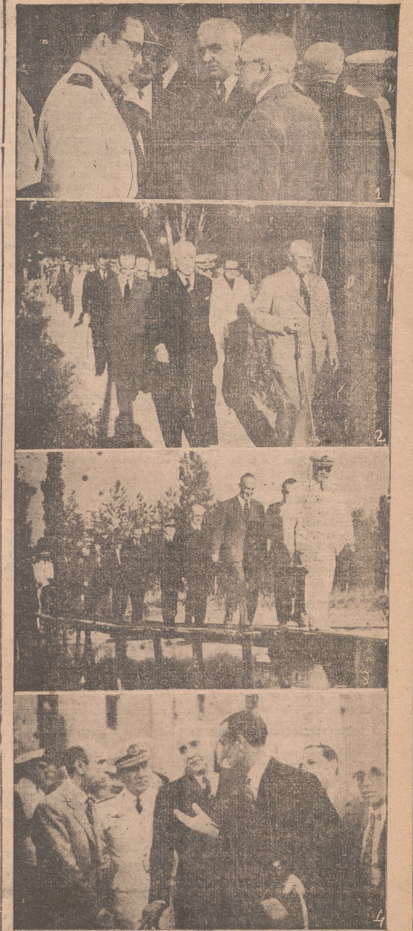
1. El ministro de Obras Públicas con el gobernador civil y los Ingenieros, en el Pantano de Mansilla.— 2. El ministro con el alcalde de Nájera y autoridades, visita las defensas del Nalerrilla.— 3. El ministro del Aire atraviesa en Nájera el puentecillo provisional sobre el Nalerrilla.— 4. El alcalde de Cenicero explica a los ministros el problema de la ciudad.
