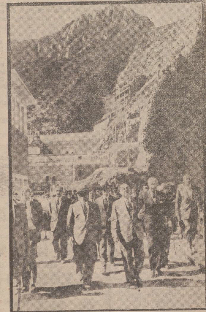
ESCALES. --- S. E. el Jefe del Estado y las personalidades de su séquito durante su visita a la presa de Escalles, donde inauguró una central eléctrica.—(Foto Cifra)
