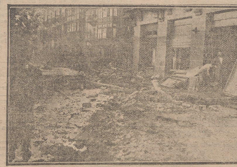
RENTERIA.—Aspecto de una de las calles después de la retirada de las aguas. La (X) señala la altura alcanzada por aquellas. (Photo Carte)
