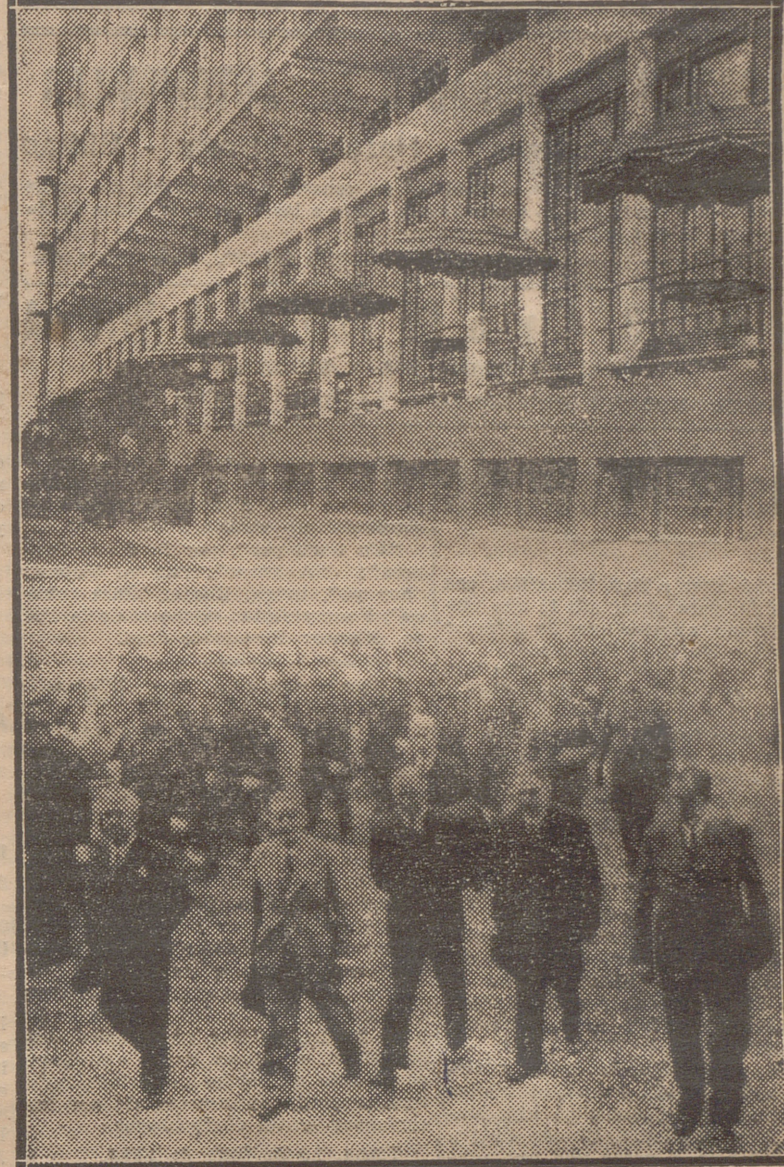
UN ASPECTO PARCIAL DE LA GALERIA ABIERTA DE LA PLANTA BAJA. ABAJO, EL SUBSECRETARIO DE GOBERNACION SEÑOR ECHEGUREN Y OTRAS AUTORIDADES
