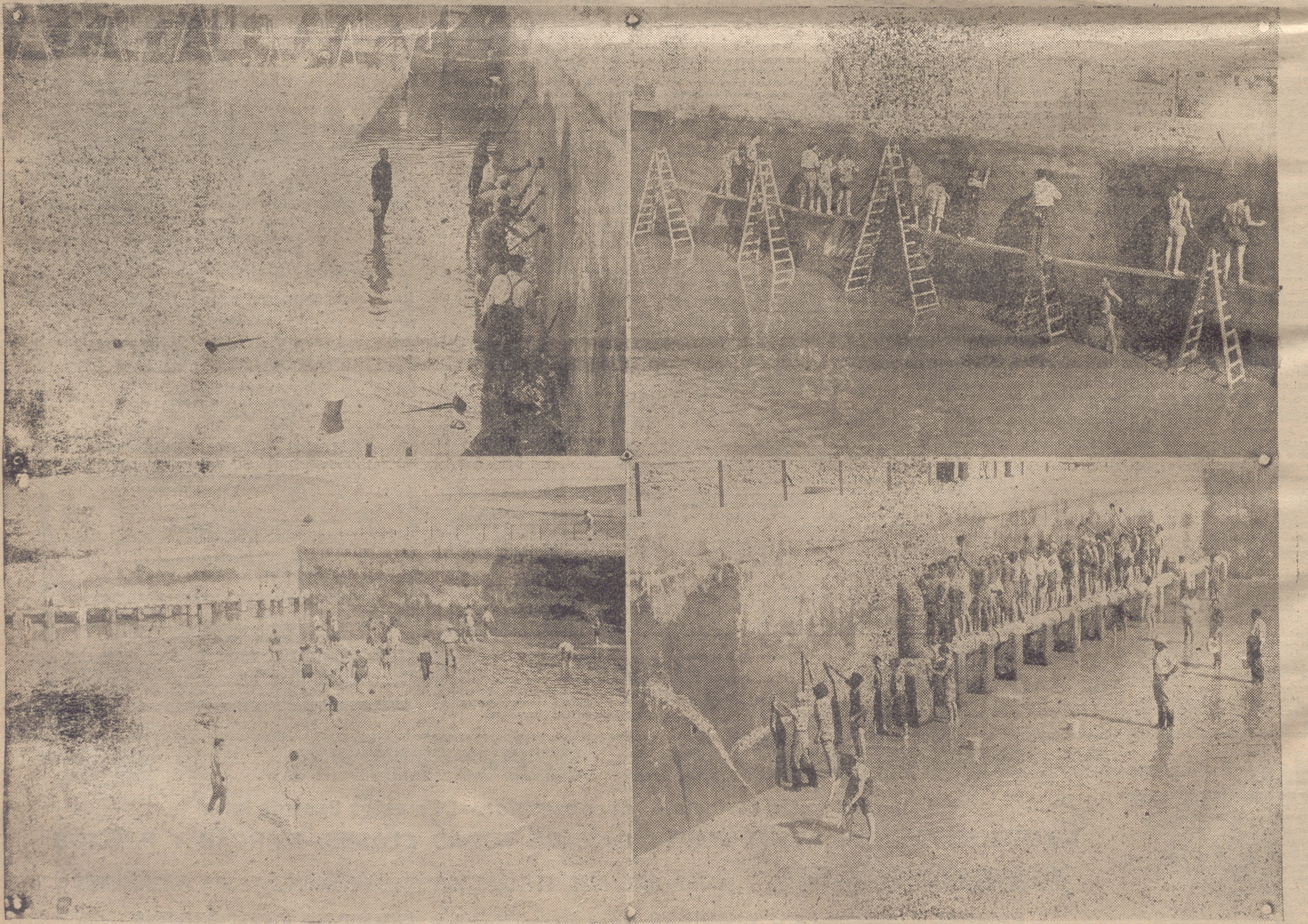
Ayer se procedió a una rápida limpieza del depósito grande del servicio de aguas potables de la ciudad. La labor era muy necesaria y había que realizarla tan concienzuda como presurosamente, a fin de que pudiera ser utilizado nuevamente a breve plazo. — Estimularon a los trabajadores el primer teniente de Alcalde don Enrique Amelvia y el gestor señor Gil López y el ayuntamiento obró de alicate tomando parte en la labor a fin de hacerse imitar. En estas fotos Limorti ha recogido algunos de los momentos del trabajo realizado bajo la caricia de un sol picante, y los representantes del Ayuntamiento debieron quedar muy satisfechos del esfuerzo realizado en beneficio de la normalidad del abastecimiento y consiguiente del vecindario, pues obsequiaron a los obreros con unas riquísimas sopas con arroz, para añadir a su comida y un paquete de cigarrillos.
