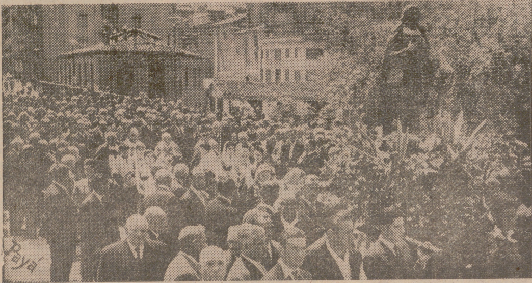
Magnífico aspecto que ofreció a la procesión del Santo a su paso por el Puente de Hierro
