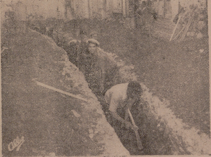
Los vecinos de San Millán están empeñados en la tarea de establecer la red distribuidora de aguas y el alcantarillado. Realizan los trabajos por prestación personal.—(Foto "Albe").
