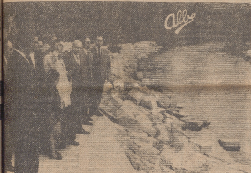
Ayer, entre las inauguraciones de obras conmemorativas del 18 de julio, figuraban las de defensa del río Najerilla en el bello pueblo de Bobadilla. En la foto, momento de la bendición de las mismas.
